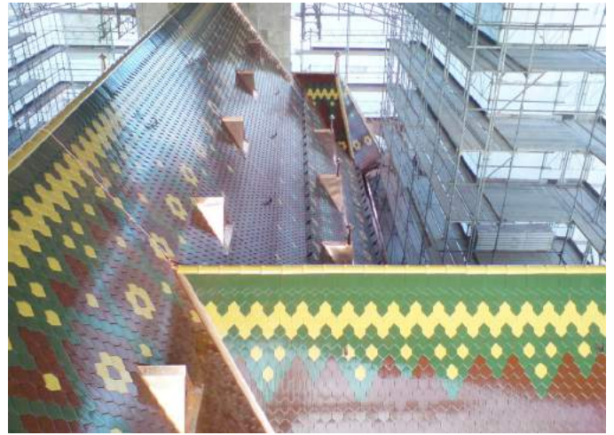
Innenraum Richtung Süd (Bauphase 2015)
